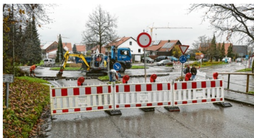
Am Kreisverkehr in Oberach laufen seit Montag Bauarbeiten. Das Bild zeigt die Vollsperrung der Kreisstraße am Kreisverkehr von Osten her, also aus Richtung Rehling. Foto: Josef Abt
