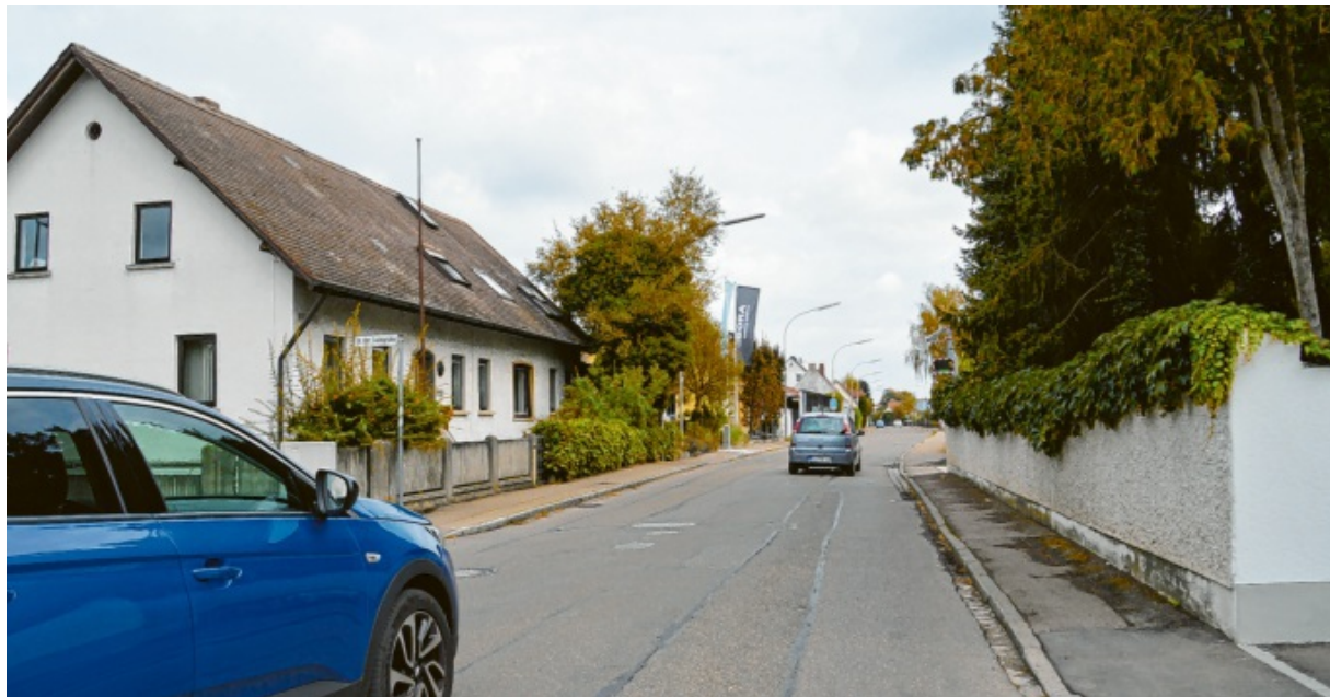
Die Johannesstraße in Lauingen präsentiert sich derzeit in einem eher unschönen Zustand. Das soll geändert werden – auch wenn die Pläne nicht überall gut ankommen. Foto: Andreas Schopf
