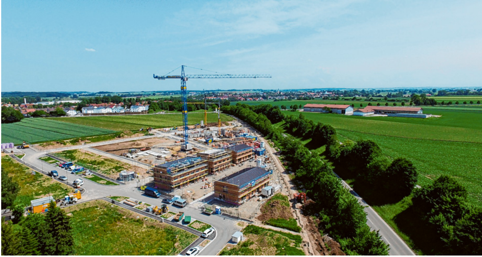
Am Meringer Oberfeld entsteht derzeit ein neues Wohngebiet und es geht rasch voran. Zur B2 laufen schon die Arbeiten für die Lärmschutzwand, wie auch diese Drohnenaufnahme zeigt. Dadurch wird jedoch die bisherige Baustellenzufahrt unpassierbar und die Laster rollen durch die Wohngebiete. Foto: Firma Dumberger
