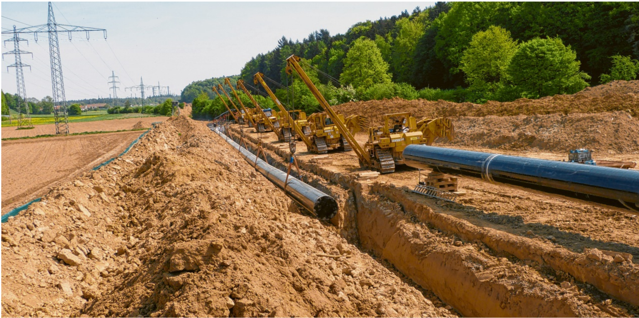
Für den Bau einer Gastransportleitung muss viel Erde bewegt werden. Hier sieht man den Bau der 87 Kilometer langen Leitung „Monaco“, die vom oberbayerischen Finsing nach Burghausen führt. Foto: Bayernets GmbH
