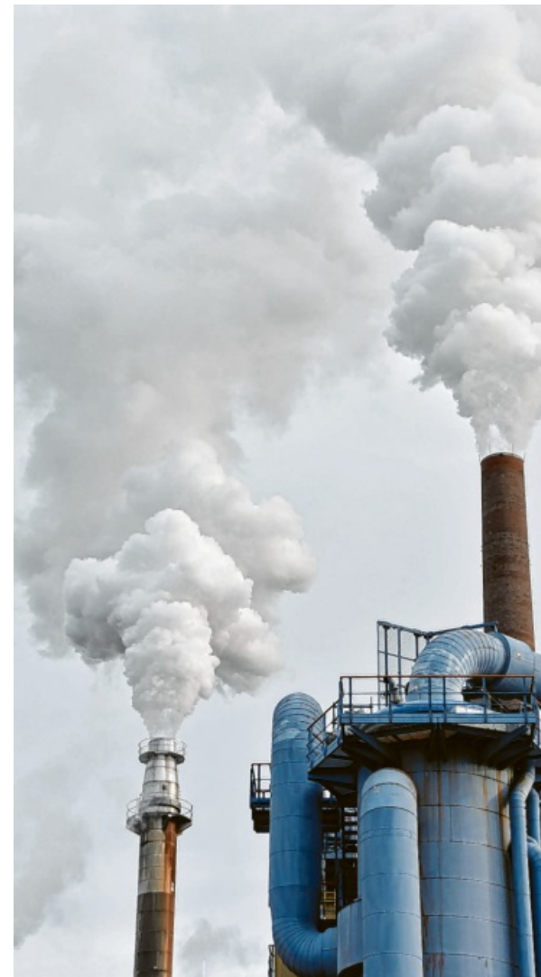
Seit 127 Tagen sind die Dampfwolken weithin zu sehen.
