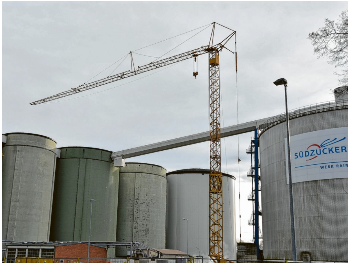
In diesem Bereich des Südzucker-Werks in Rain wird eine Verladeanlage gebaut. Fotos: Wolfgang Widemann
