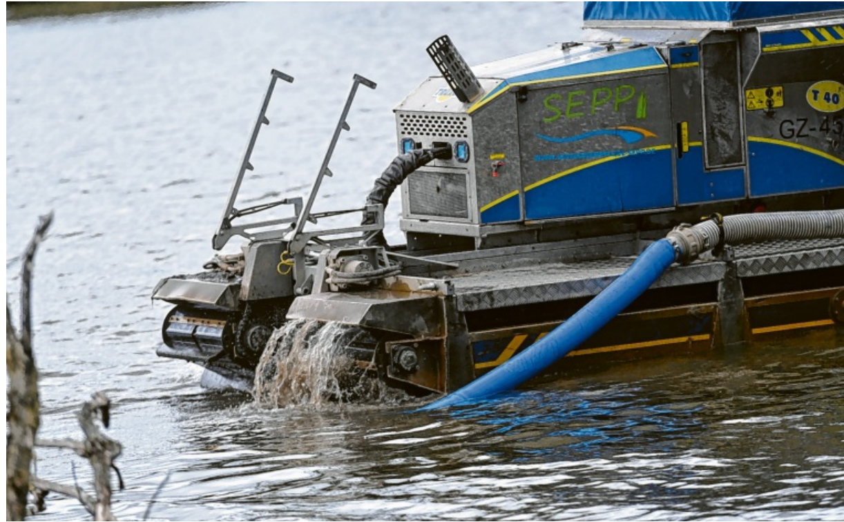
Mit schwerem Gerät sind die Zusmarshausener im Sommer gegen den Schlamm im Rothsee vorgegangen. Jetzt wird die Roth ins Visier genommen. Foto: Marcus Merk
