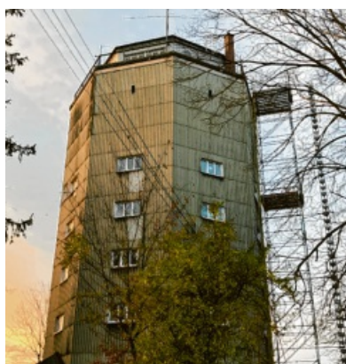
Die Sanierungsarbeiten im Friedberger Wasserturm laufen nach Plan. Foto: Anna Faber
