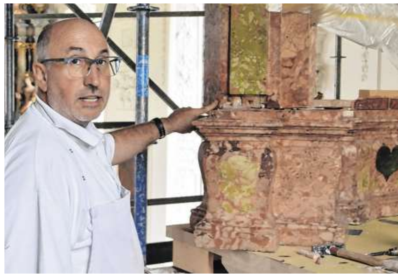
Thomas Salveter mischt winzig kleine Gipshäufchen mit Natur-Erdfarben, mit denen er bei den Altären mit einer Fugenkelle die Beschädigungen kunstvoll ausbessert.
