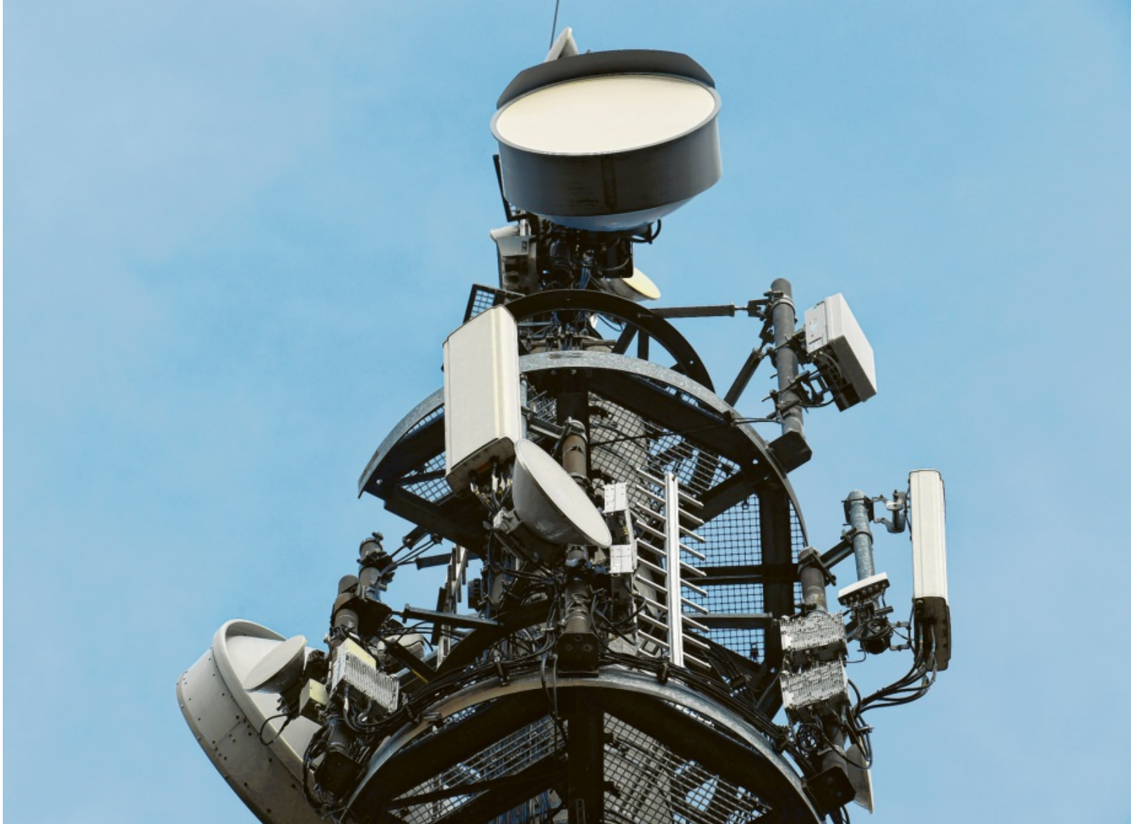
Für das 5G-Netz, das man für selbstfahrende Autos braucht, reichen die großen Antennenstandorte nicht mehr aus. Dafür müsste ein engermaschigeres Netz aufgebaut werden. Foto: Soeren Stache, dpa (Symbolbild)
