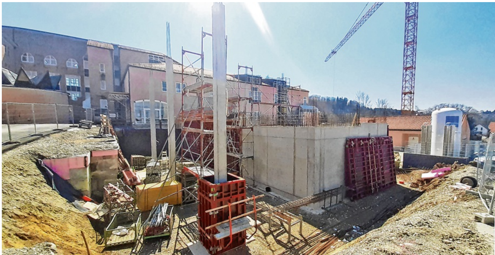
Wegen der Corona-Pandemie wurden die Bauarbeiten am Ottobeurer Krankenhaus nun zum Großteil ausgesetzt. Das Foto zeigt die im Bau befindliche neue Intensivstation der Klinik. Foto: Andreas Kleine/Klinikverbund
