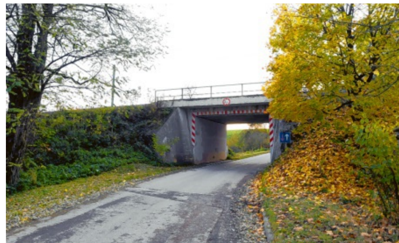
Der Gemeinderat von Zusmarshausen hat sich dagegen entschieden, die Bahnunterführung in Gabelbach neu zu bauen. Foto: Marcus Merk
