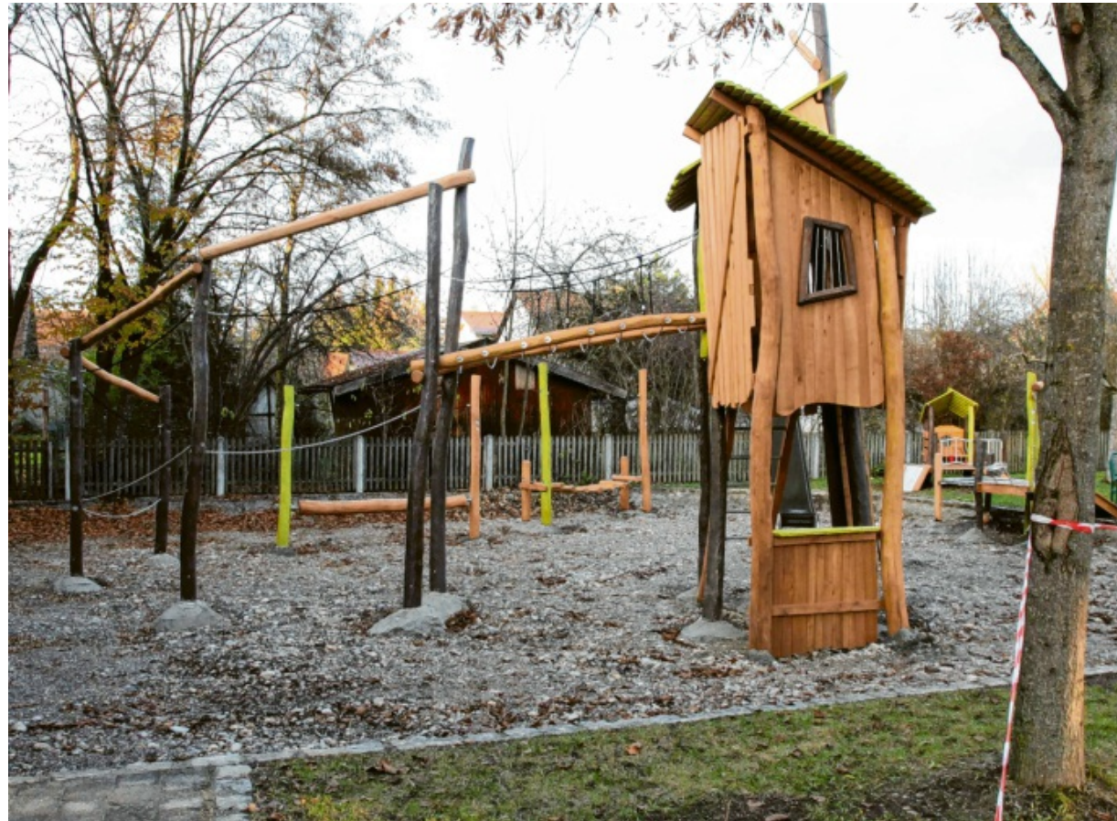
Die lang ersehnte Eröffnung des erneuerten Spielplatzes am Feststadel verzögert sich noch um einige Wochen, da die Firma die langen Robinienstämme der Spielanlage tiefer ins Fundament einsetzen muss. Foto: Sybille Heidemeyer
